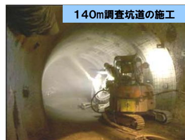
低アルカリ性コンクリート材料による坑道吹付け施工技術の実証
